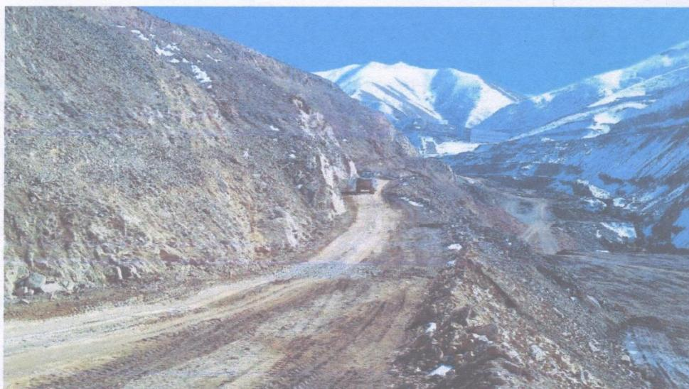
Рис. 2. Технологические дороги при освоении месторождения Галдыбулак-Левобережный
